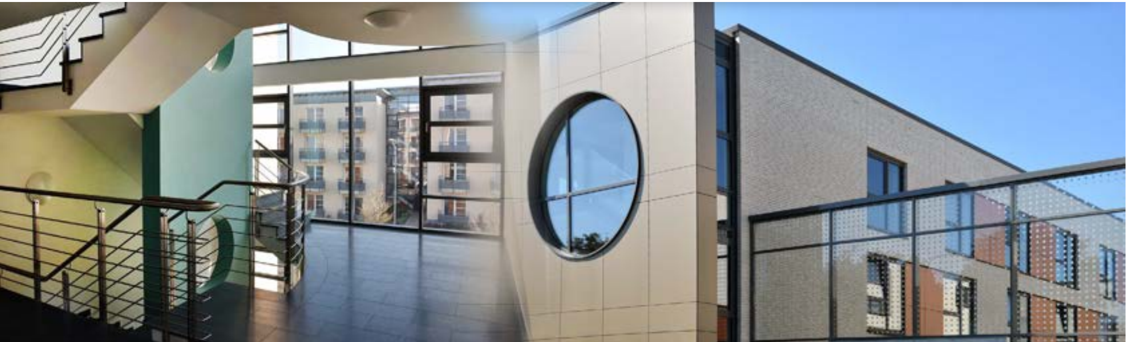
Großzügig und attraktiv gestaltete Treppenhäuser im Wohn- und Gästepark am Mersinweg. | Ansprechende Architektur der Wohnanlage Alois-Fuchs-Weg.
