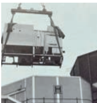
Anlieferung der neuen Spülmaschine war nur über das Dach möglich
